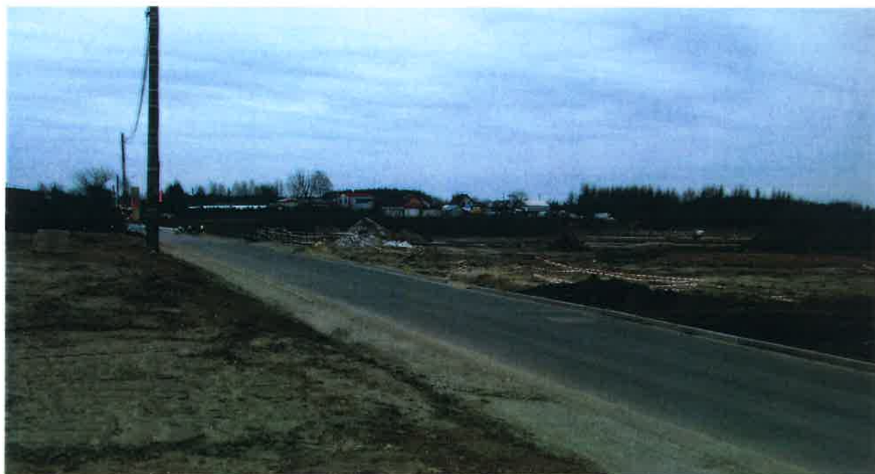
Rys. nr 12 Stan zagospodarowania terenu po wykonaniu podstawowych robót naprawczych, marzec 2018 r.
