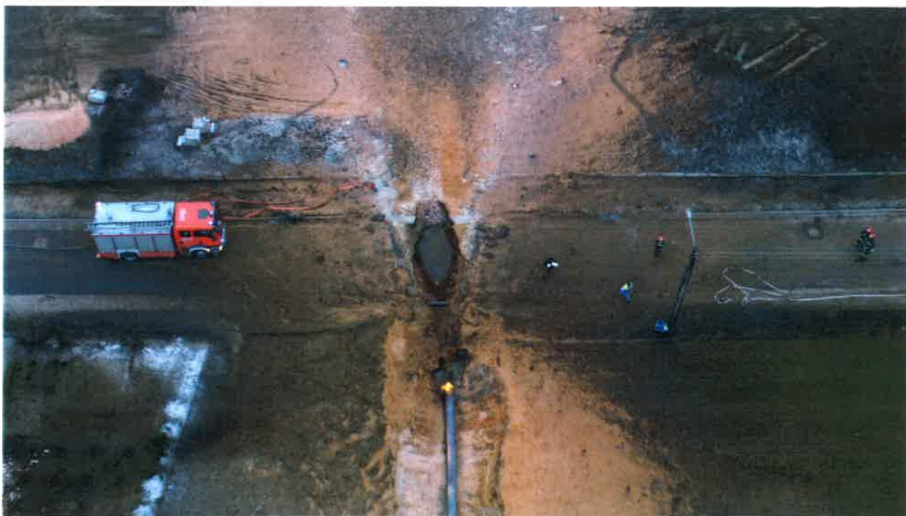
Rys. nr 8. Katastrofa budowlana gazociągu DN500 Poznań-Rogoźno, 26 stycznia 2018 r.
