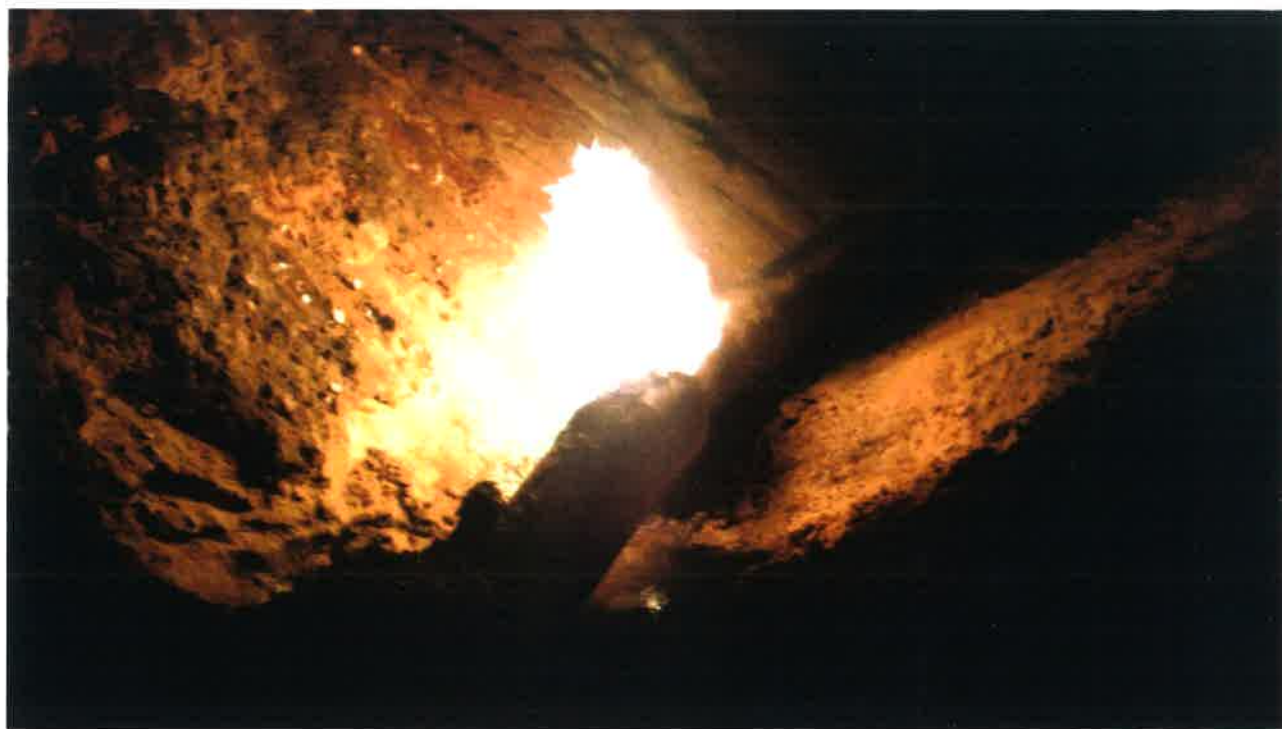
Rys. nr 6. Katastrofa budowlana gazociągu DN500 Poznań-Rogoźno, 26 stycznia 2018 r.
