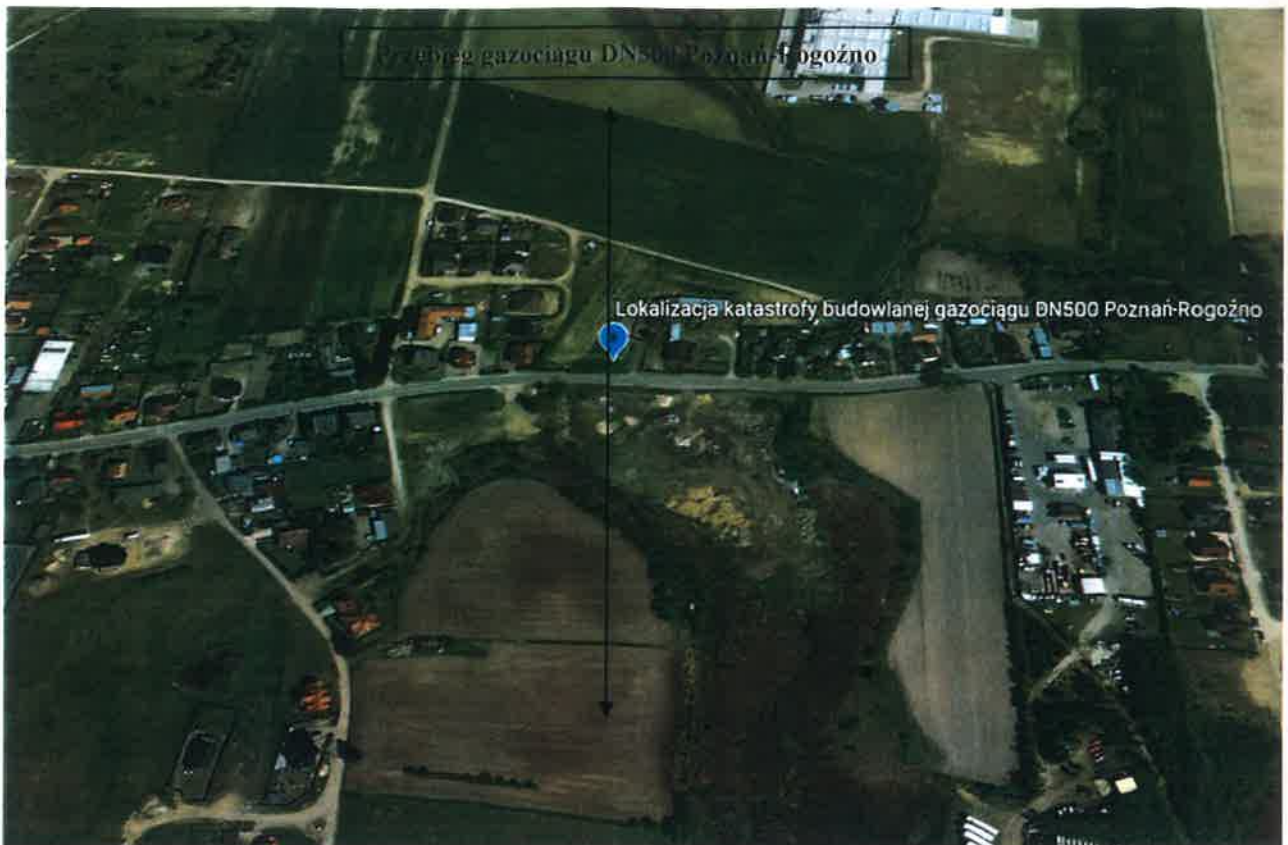
Rys. nr 3 Lokalizacja katastrofy budowlanej gazociągu (źródło mapy: Mapy Google, zdjęcie terenu z okresu przed 26 stycznia 2018 r.).
